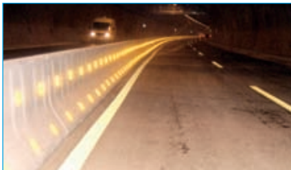
Integrierte Reflektoren für mehr Sicherheit im Baustellenbereich bei Dunkelheit oder im Tunnel
