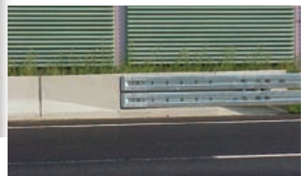
Betonschutzwand-Fertigteile sind wirtschaftlich, langlebig und sicher, auch im Verbund mit anderen Systemen.
