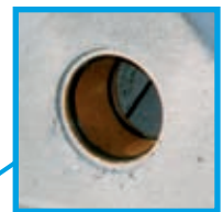
Versorgungsöffnung zur Aufnahme der vier Druckspiralschläuche in der Version Luft- heber. Schlauchlänge max. 25 m.
